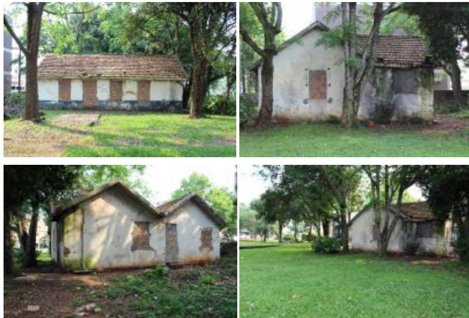
FIGURA 7 – Imagens do levantamento feito em 2016 - Casa da guarda.
